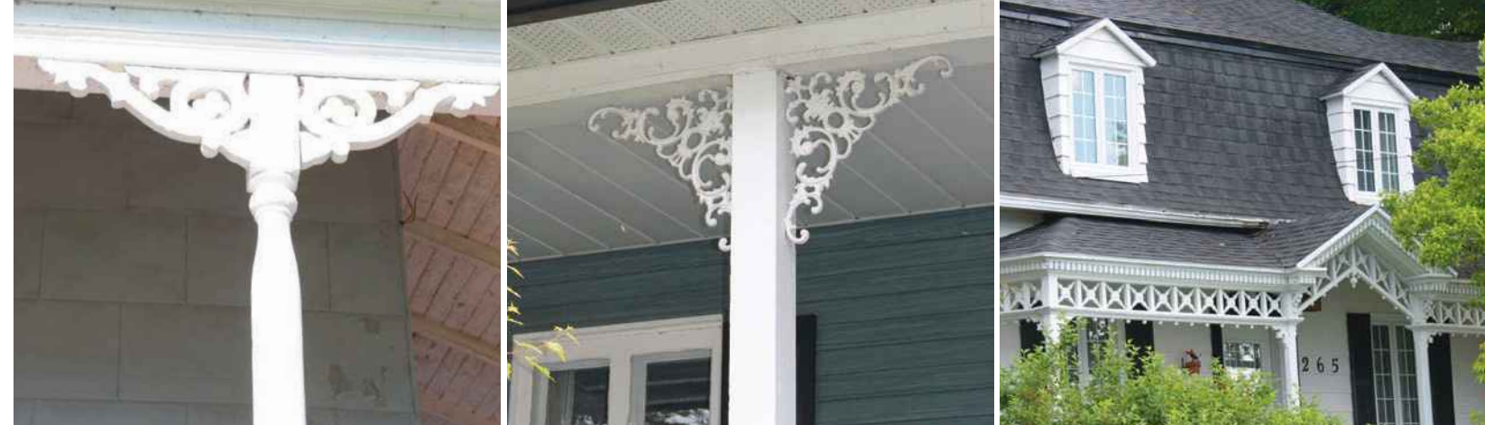
Quelques modèles de consoles et lambrequins présents sur des maisons de Saint-Augustin-de-Desmaures
