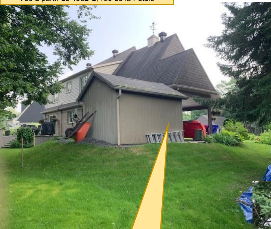
Remise à démolir Futur emplacement du garage
