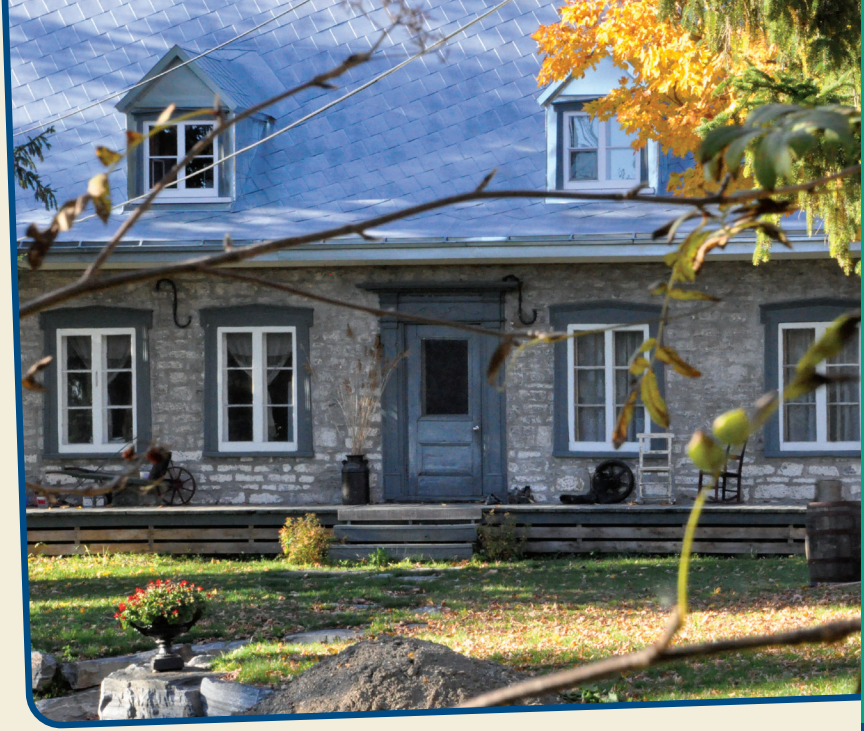
La maison Quézé construite en 1750
