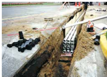
Installation des conduits
