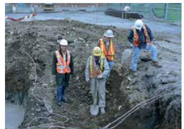
Remblayage et réfection de surfaces
